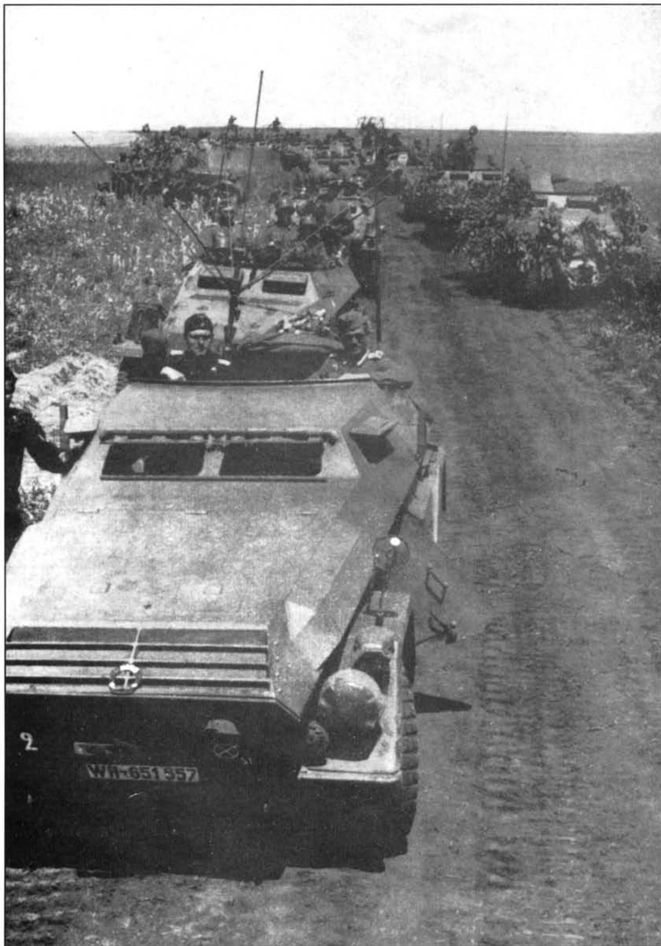
Колонну бронетранспортеров возглавляет броневедомобиль SdKfz 247 II, созданный на базе тяжелого пассажирского шасси Horch. Эти броневедомобили имели ограниченную проходимость и в них обычно ездили высшие командиры и члены штаба.
