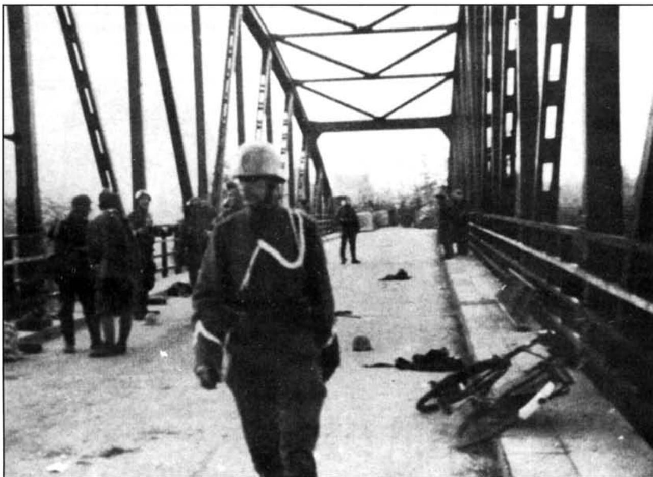
Мост через канал Юлиана в Голландии был взят подразделениями полка "Brandenburg".
