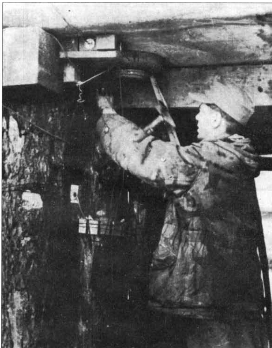
Сапер закладывает фугасный заряд под настил деревянного моста.
