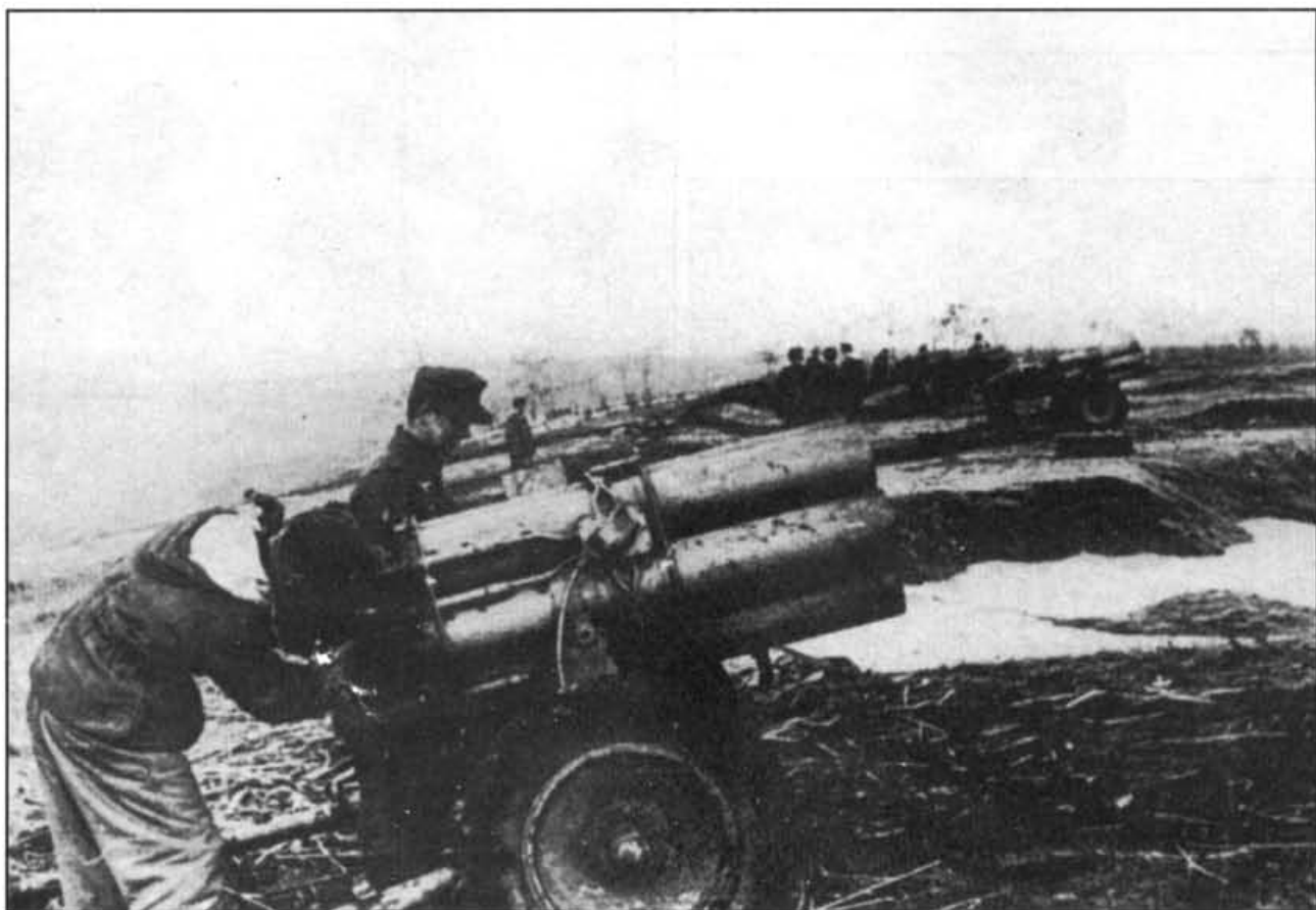
Заряджание 15 см Nebelwerfer. Пуск мин осуществляется дистанционно.
