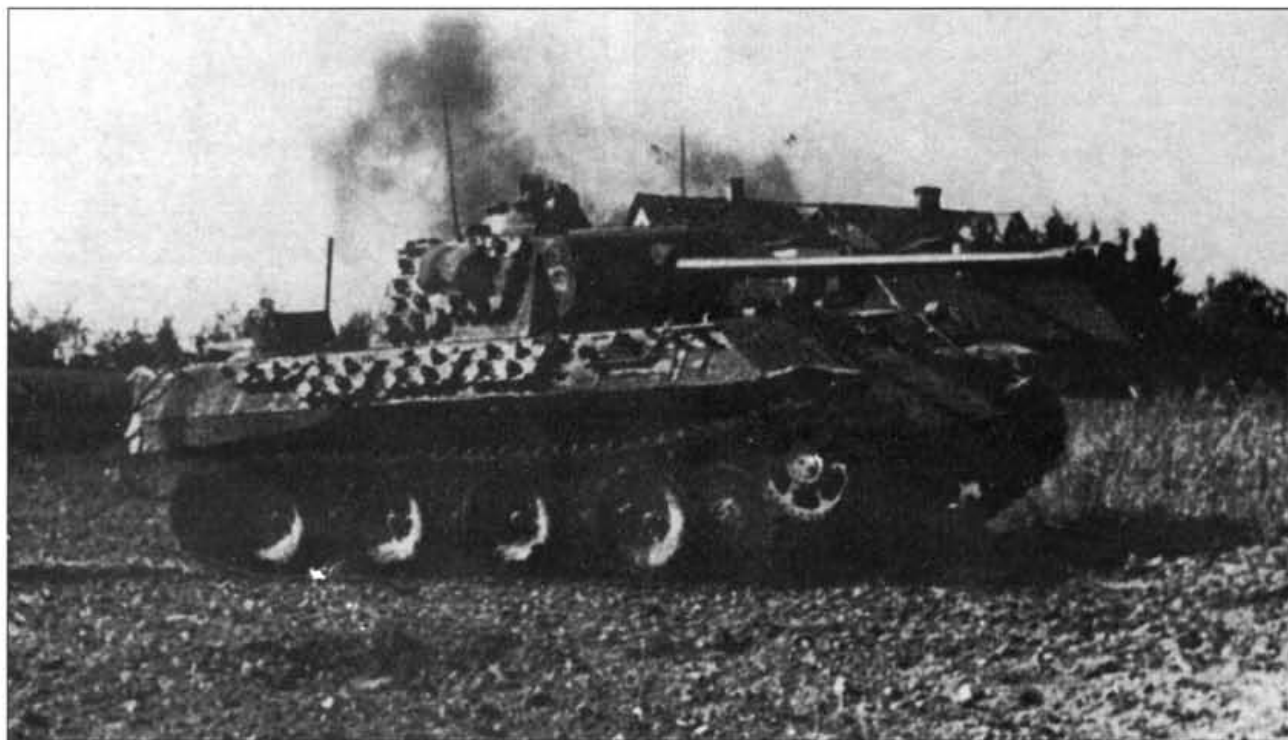
PzKpfw V "Panther" Ausf. A из Pz.Rgt. 26 движется мимо горящих домов. Как это было принято в то время, запасные гусеничные траки развешаны по бортам башни и корпуса. Танковый батальон дивизии "GD" в это время сражался на Западном фронте.
