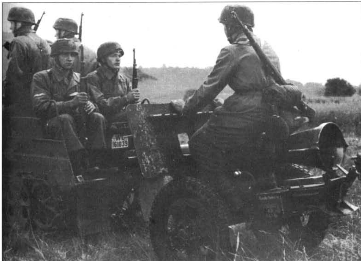
Параютисты при помощи полугусеничного мотоцикла буксируют 105-мм безоткатную пушку LG 40
