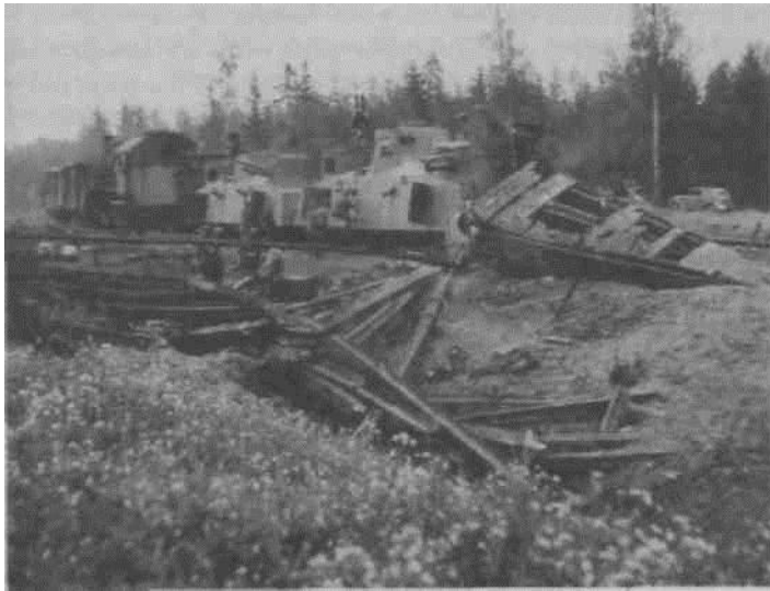
Поврежденный БЕПО-МБП НКВД
