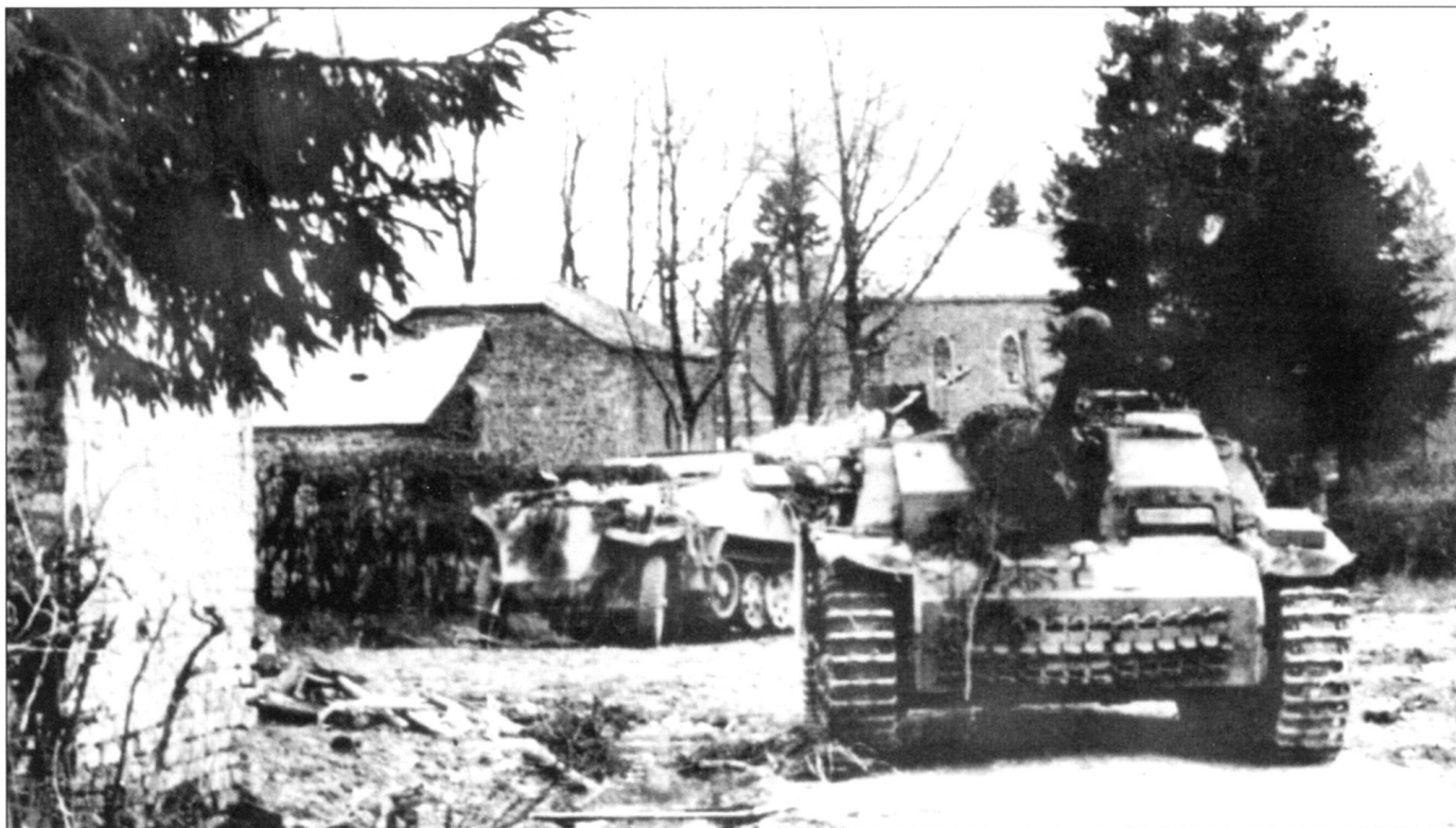
Штурмовое орудие StuG III Ausf. G и полугусеничный бронетранспортер Sd.Kfz. 251/1 Ausf. D, брошенные под Манхэем. Штурмовое орудие – позднего выпуска, покрыто циммеритом, на крыше смонтирована дистанционно управляемая пулеметная установка, также стоит отметить 80-мм накладную бронеплиту в левой лобовой части рубки, фиксатор ствола орудия в походном положении и дефлектор перед командирской башенкой.
