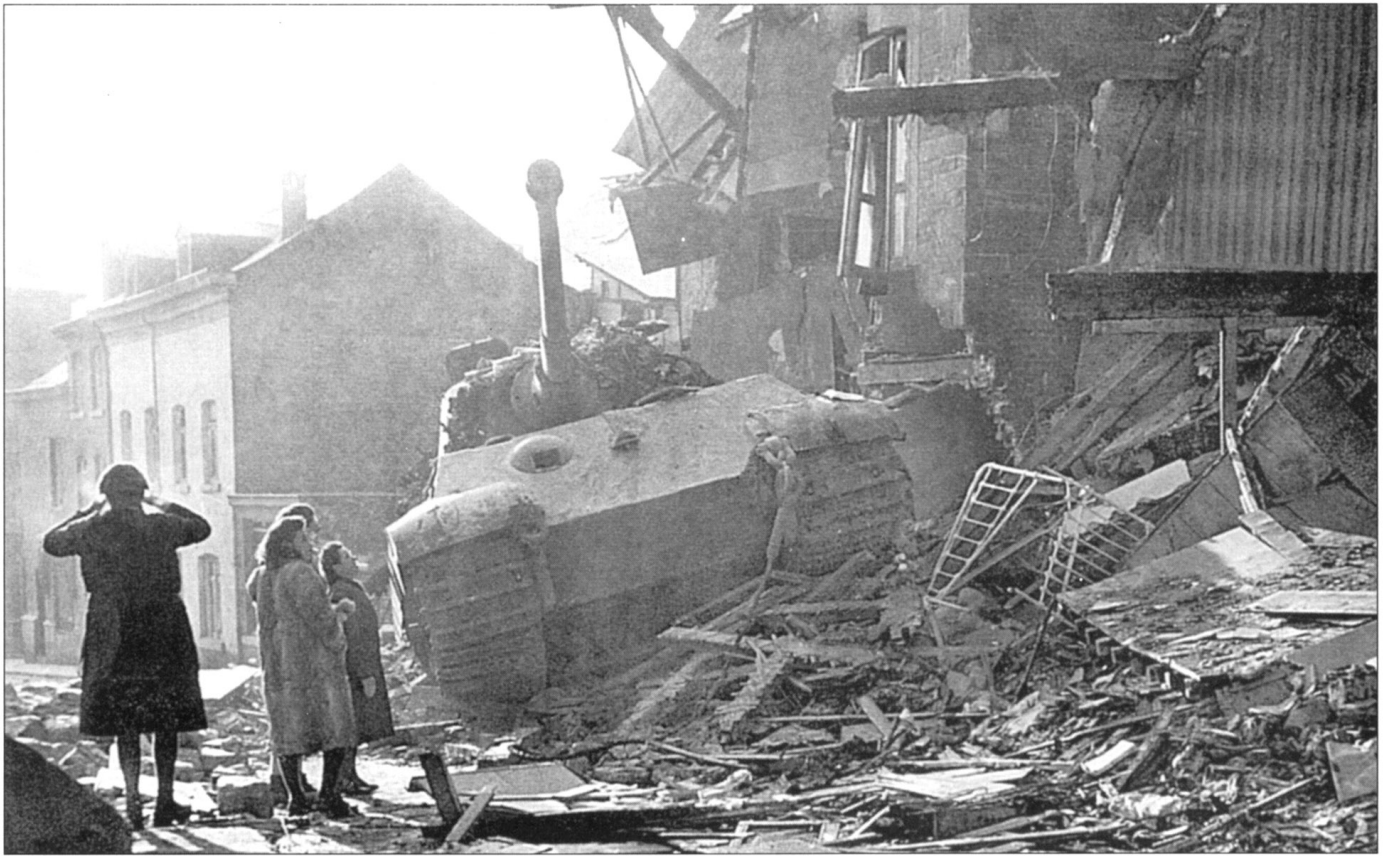
«Королевский Тигр» с бортовым номером «105» из 501-го тяжелого танкового батальона (командир танка оберштурмфюрер СС Юрген Визель), подбитый на руинах здания. Механик-водитель разворачивал машину и подставил борт танка американской базуке. Основные силы Kampfgruppe Peiper прошли Сквельот утром 18 декабря, а «Королевские Тигры» вошли в город позже и встретили сопротивление небольшого количества американских воинов. Этот «Королевский Тигр» - первая потеря 501-го батальона в Арденнах.
