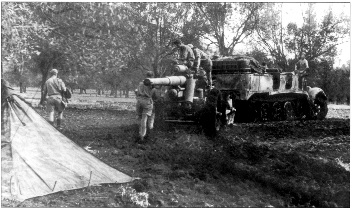
Артиллерийское орудие 15 см sFH-18 на прицеле у полугусеничного тягача Sd.Kfz. 7, пушечный поезд маневрирует среди оливок. На переднем плане - собранная из четырех плащ-накидок zelbtbahn палатка. Тягач полностью покрашен в темно-желтый цвет и камуфлирован пятнами зеленого цвета.
