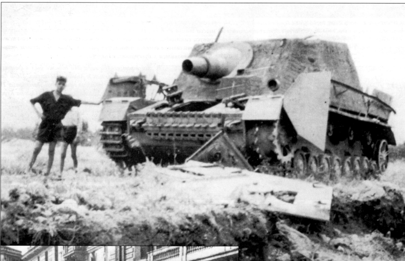
Sturmpanzer IV среднего выпуска был брошен под Анцио. Самоходку осматривают итальянские пацины. Внутренним взрывом сорвало крышу боевого отделения, разворотило лобовую часть корпуса, крыша рубки валяется на земле перед самоходкой. Самоходка оснащена новыми стальными литыми ленивцами, которые стали ставить на танках Pz.Kpfw. IV Ausf. H в октябре 1943 г.
