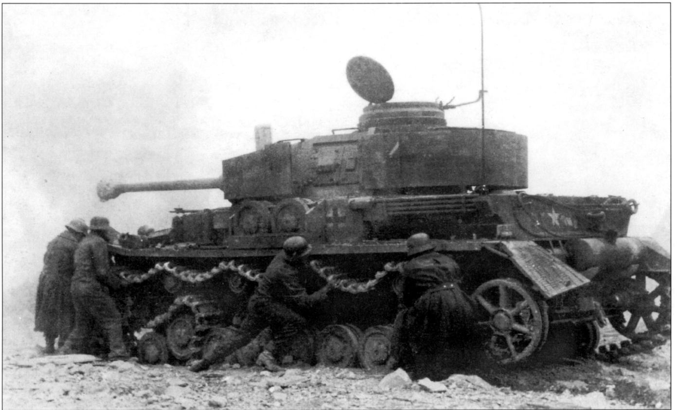
Экипаж танка Pz.Kpfw. IV Ausf. H натягивает гусеницу, скорее всего гусеница просто слетела при резком повороте танка - следов боевых повреждений на танке не заметно. На корме корпуса нарисована белая пятиконечная звезда, обозначающая принадлежность танке не армии США, но 15-й панцергренадерской дивизии вермахта. Рядом со звездой белой краской изображены ромбический символ танкового подразделения и цифра «2» - номер роты.
