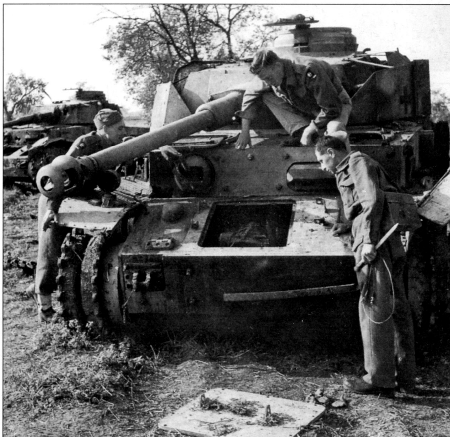
Трое британских солдат из 78-й пехотной дивизии осматривают подбитый танк Pz.Kpfw. IV Ausf. G, Сан-Сальво, побережье Адриатики, ноябрь 1943 г. В лобовой части корпуса танка на болтах установлена накладная броня толщиной 30 мм, в верхнему бронелисту корпуса 30-мм накладная бронеплита приварена. Левее смотровой щели механика-водителя изображен небольшой крест. Гусеницы на танке отсутствуют. Обратите внимание на большое количество грязи, набившейся между зубчатыми венцами ведущего колеса. У солдата на переднем плане висит на боку германский полевой телефон.
