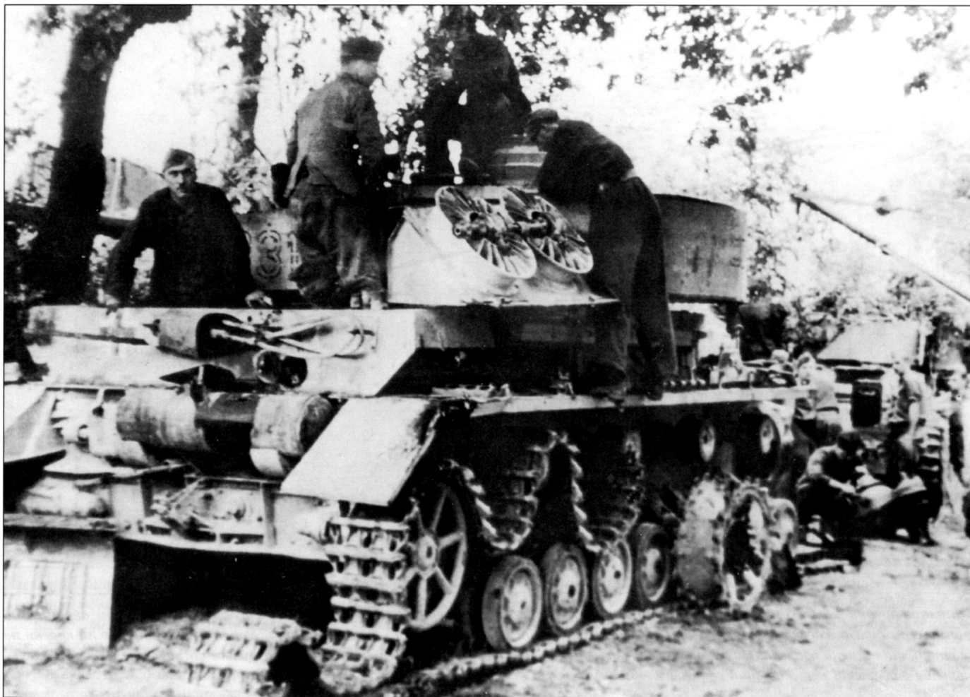
Танк Pz.Krfw. IV Ausf. G из 2-го батальона 2-го танкового полка 16-й панцердивизии на ремонте в дивизионных мастерских. На бортовом башенном экране видна часть тактического номера «231» или «331». Эмблема дивизии - буква «Y» с двумя горизонтальными штрихами - нарисована краской цвета желтой охры и обведена черным кантом, эмблема дивизии просматривается на кормовом бронелисте корпуса левее креста. В этот период 16-я панцердивизия имела на вооружении 2-го батальона танки Pz.Krfw. IV, а на вооружении 3-го батальона - штурмовые орудия StuG III; 1-й батальон находился в Германии в процессе перевооружения танками «Пантера».
